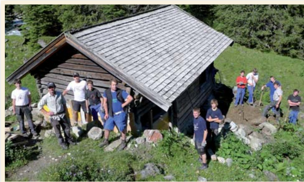
Schüler des PTS bei Sanierungsarbeiten
