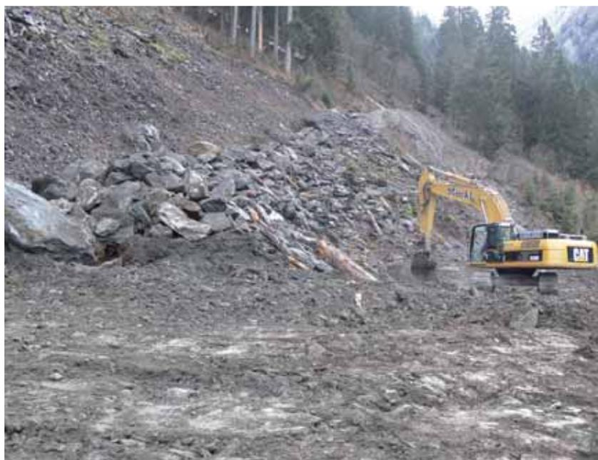
*An der Gefahrenstelle wird der Wegabschnitt verlegt und ein Schutzwall errichtet.*
